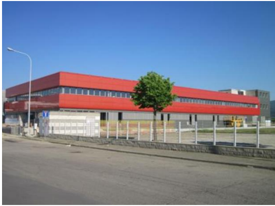
Figura 5: Immagine esterna del Datacenter
